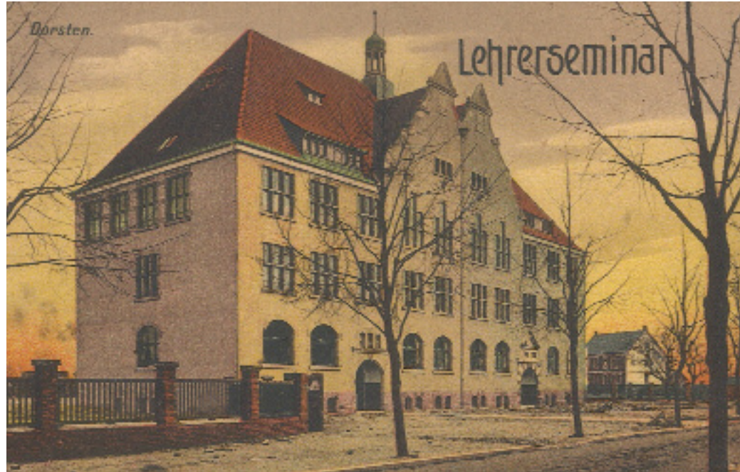
Für das Lehrerseminar in Dorsten wurden 1909 umfangreiche Sanierungsarbeiten ausgeführt.
